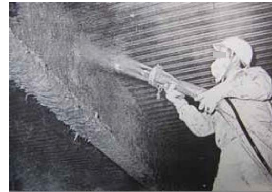
鉄骨の梁(はり)に耐火被覆として吹きつけているところです。この作業周辺は粉じんが舞っていて、作業や周辺で作業をしていた者が高濃度ばく露した可能性があります。
