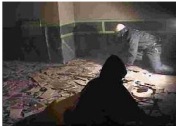
天井の石綿セメント板(フレキシブル板)をバールで破壊し、かき集めているところ。破碎に伴い、粉じんが舞っています。
