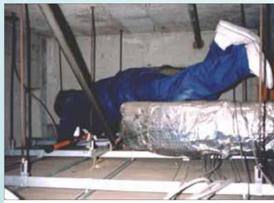
電気工による天井内で横に這いながらの作業で、写真の下に部屋があります。電気工、水道工、ダクト工、衛生設備工は天井内作業があり、写真はありませんが天井に石綿吹きつけがある場合、壁をこすって、石綿にばく露することがあります。
