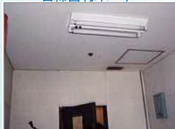
天井/石綿含有吸音板、 壁/石綿含有けい酸カルシウム有穴板
