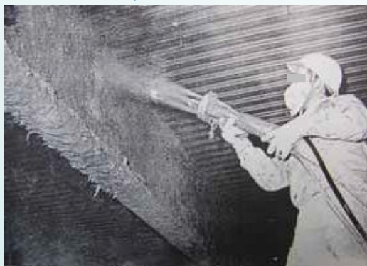
鉄骨の梁(はり)に耐火被覆として吹きつけているところです。この作業周辺は粉じんが舞っていて、作業者や周辺で作業をしていた者が高濃度ばく露した可能性があります。
